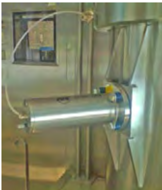
Abreinigen von Rohren
