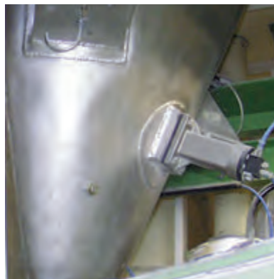
Abreinigen von Bunkerwänden
