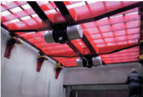
Sieben von grobem Schüttgut mit Elektro-Außenvibratoren
